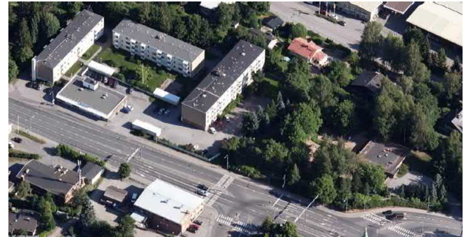
Kuva: 8764 Ilmakuva, jossa näkyvät purettaviksi aiottu opiskelijatalot ja päiväkotit sekä parannettavaa Messukylänkatua.
